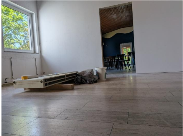
Im neu geschaffenen Geräteraum stehen 30 Quadratmeter zur Verfügung.
